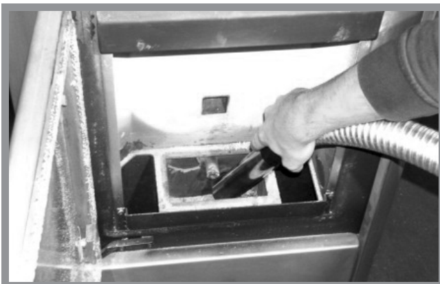
Abb. 12f: Reinigung Brennraumbehälter
