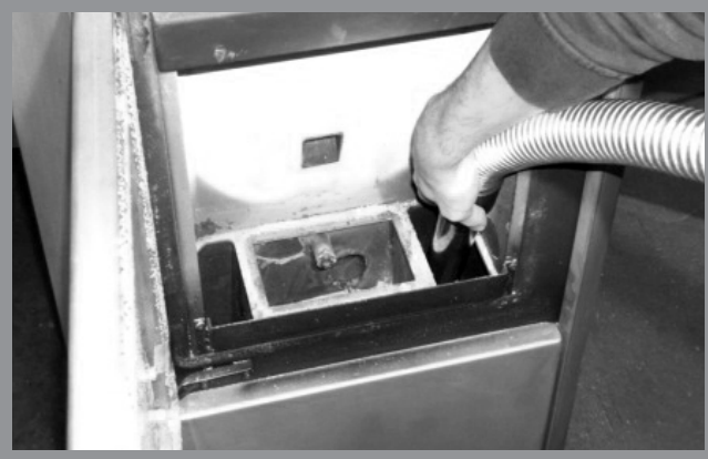
Abb. 12g: Reinigung untere Brennkammer
