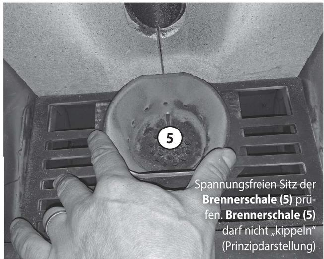
Spannungsfreien Sitz der **Brennerschale (5)** prüfen. **Brennerschale (5)** darf nicht „kipeln“ (Prinzipdarstellung)
