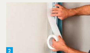
2. Trenn-Fix neben Profil kleben
