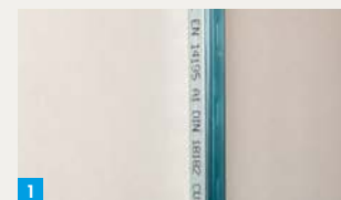
1. Profil auf angrenzendes Bauteil montieren
