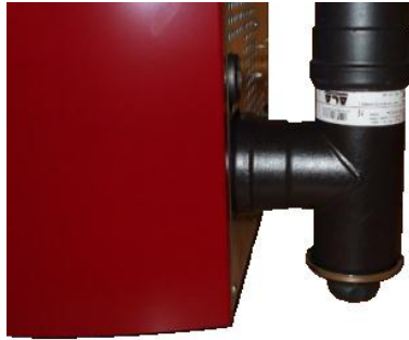
Fig. 75 - Reinigung des Rauchgaskanals
