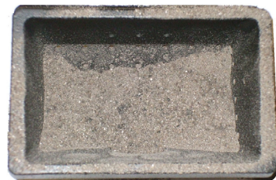
Fig. 72 - BEISPIEL VERSCHMUTZTE BRENNSCHALE
