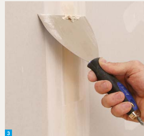
3. Ausgehärtetes Material nach ca. einer Stunde abstoßen.
