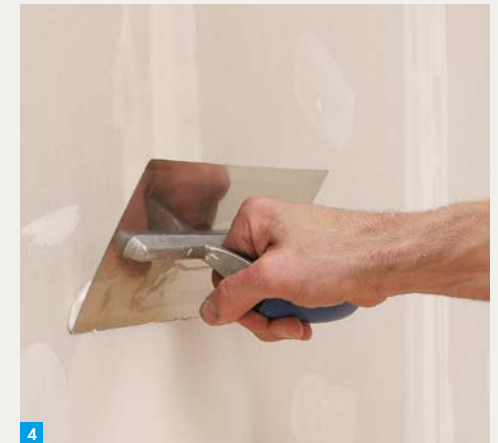
4. Knauf Uniflott Finish mit der Traufel auftragen und glatt abziehen. Nach Trocknung gegebenenfalls schleifen.
