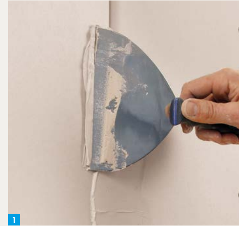
1. Knauf Uniflott in die Gipsplattenfuge einbringen.
