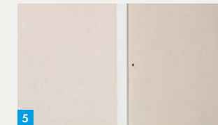
5. Gipsplatten mit ca. 5 mm Abstand montieren
