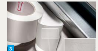
3. Schmale stark haftende Klebezone direkt an das Profil anschließen
