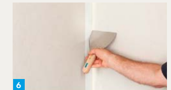
6. Fuge mit Uniflott verspachteln
