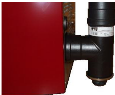
Fig. 60 - Reinigung des Rauchgaskanals
