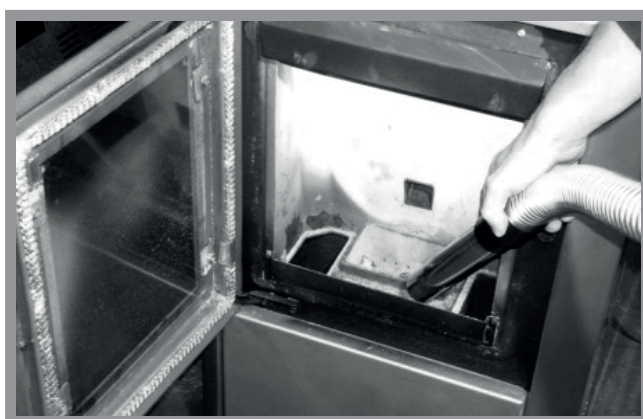
Abb. 12a: Reinigung des Brenntopfes
