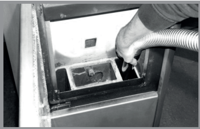
Abb. 12g: Reinigung untere Brennkammer
