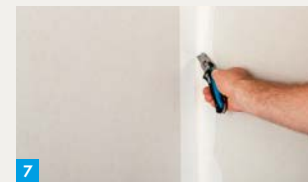
7. Nach Trocknung und Schleifen Trenn-Fix in der Ecke einschneiden
