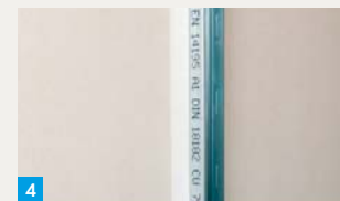
4. Trenn-Fix andrücken und glatt streichen
