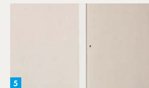
5. Gipsplatten mit ca. 5 mm Abstand montieren
