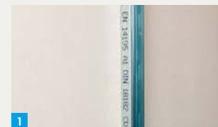
1. Profil auf angrenzendes Bauteil montieren
