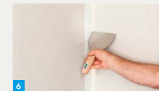
6. Fuge mit Uniflott verspachteln
