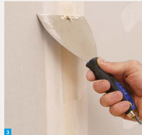
3. Ausgehärtetes Material nach ca. einer Stunde abstoßen.
