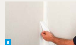
8. Überstehenden Streifen abziehen
